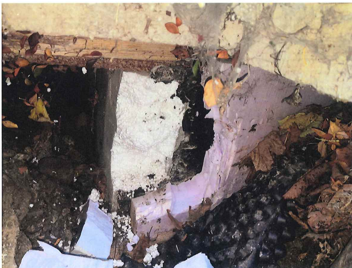
Fot. 8. Odkrywka O3 – szczegół
