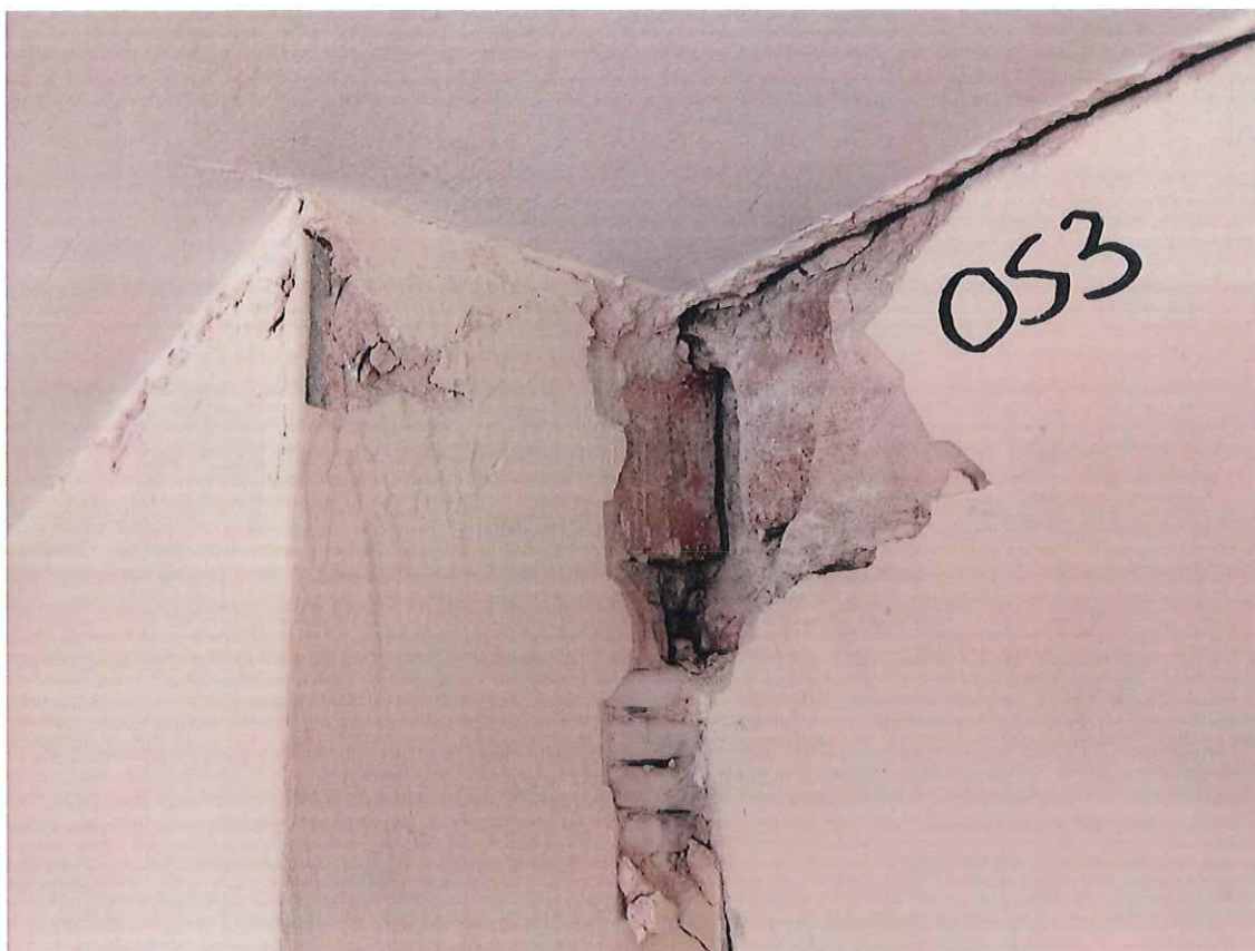
Fot. 45. Odkrywka OS3 w pomieszczeniu P222
