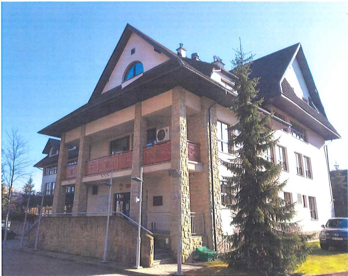
Fot. 3. Elewacje północna i zachodnia
