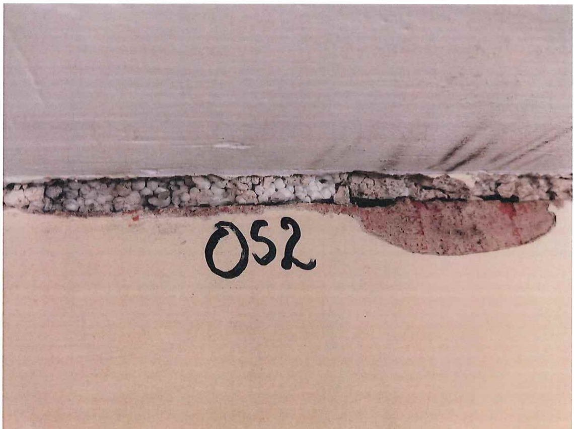
Fot. 44. Odkrywka OS2 w pomieszczeniu P222
