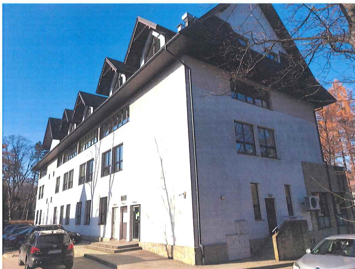
Fot. 2. Elewacje południowa i wschodnia
