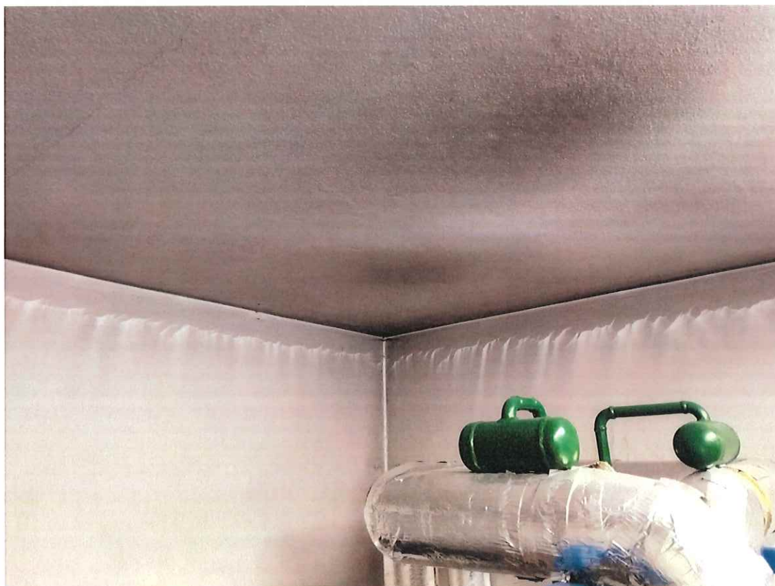
Fot. 28. Zarysowanie poziome na styku ściany piwnicy i wieńca – (pomieszczenie P06)
