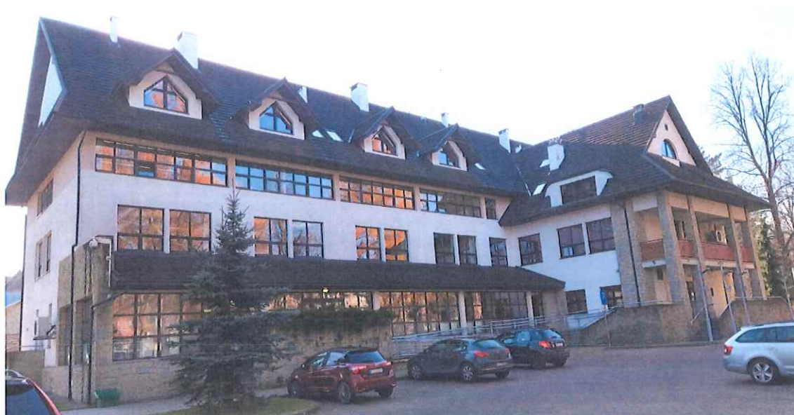
Fot. 1. Elewacje północna i wschodnia budynku będącego przedmiotem niniejszej ekspertyzy
