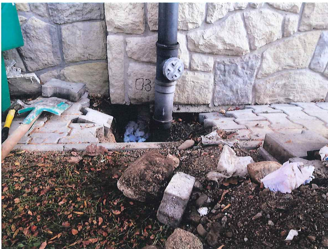
Fot. 7. Odkrywka O3 – narożnik północno-zachodni
