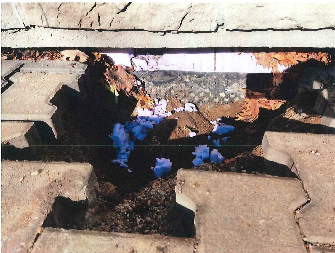
Fot. 11. Odkrywka O4 – szczegół
