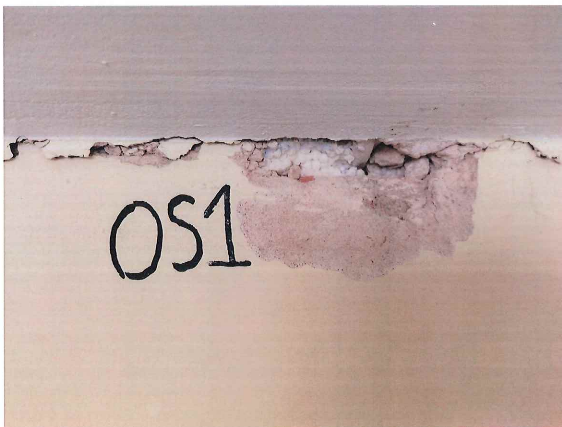
Fot. 42. Odkrywka OS1 w pomieszczeniu P120 - szczegół
