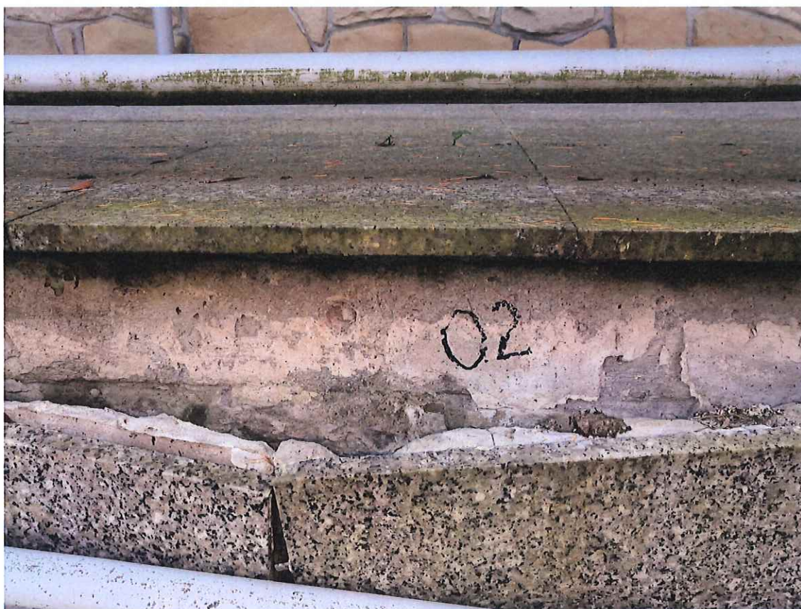
Fot. 6. Odkrywka O2 – na powierzchni bocznej pochylni
